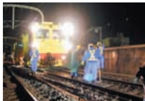
道床突固め作業
