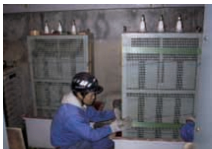
PCB廃棄物運搬準備の様子
