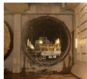
貫通した渡辺橋駅～大江橋駅間東行きトンネル
