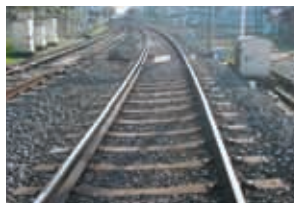
脱線防止ガードレール
